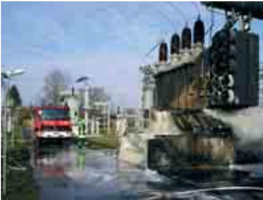
Brandschaden an einem Gerät in einer 110 kV-Freiluftanlage, Isolieröl mit Ölbindemittel gebunden
