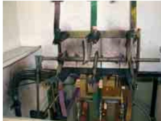
Lichtbogenschaden in einer 20 kV-Innenraumschaltanlage
