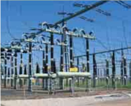
Leistungsschalter in einem 380 kV-Schaltfeld
